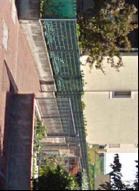
TIPOLOGIA RECINZIONE (muretto sormontato da pannelli in rete zincata)
